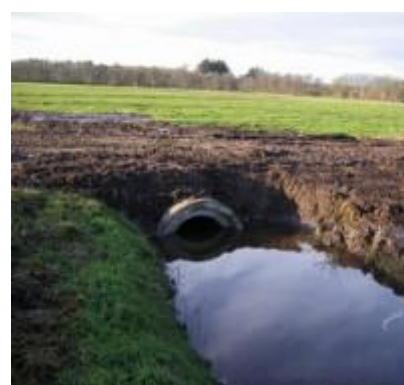
Pas geplaatste duiker in de Hulligtenloop
